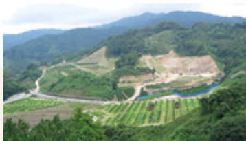
基盤整備を実施した樹園地
